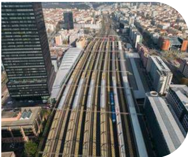
Vue aérienne de la gare Lyon Part-Dieu - Lyon 3 e
