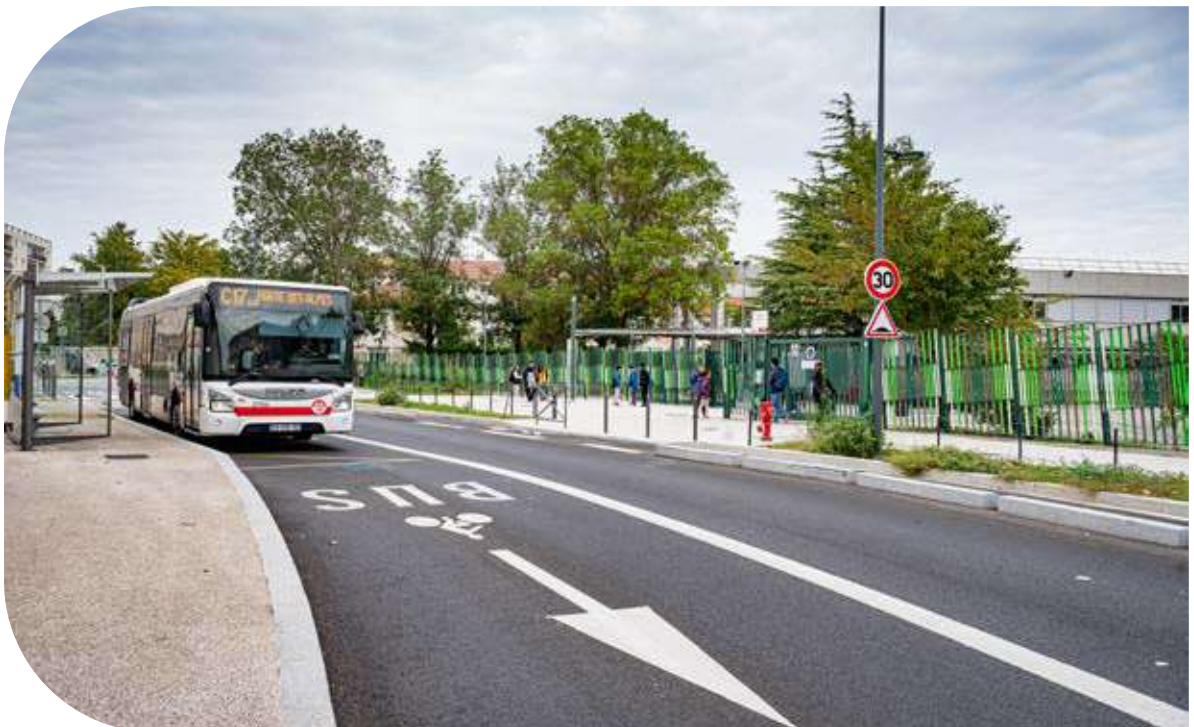
Aménagements de voirie rue du 8 mai 1945 - Villeurbanne
